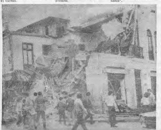
La foto muestra un edificio de Lima, capital del Perú, en estado ruinoso después de los temblores que causaron más de cien muertos y cerca de dos mil heridos.
